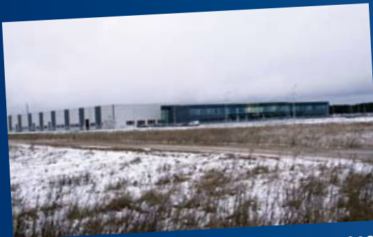
UAB „Megrame“ (2007-2008) Transformatorinių pastočių TP1, TP2, TP3, TP4 projektavimas, gamyba bei montavimas.
