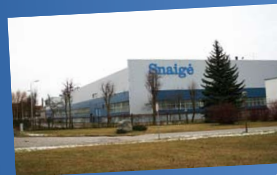
AB „Snaigė“ (2006-2008) Transformatorinių pastočių (TP-1, TP2, TP3) rekonstrukcija.
