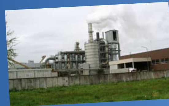
UAB „Girių bizonas“ (2006) Transformatorinių pastočių TP21, TP22, TP23, TP24 projektavimas, gamyba bei montavimas.
